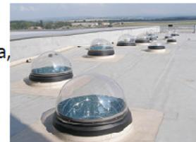
2-3. La scossalina/faldale è monoblocco, senza giunture per impedire infiltrazioni d'acqua, adatta a tetti inclinati o piani. In casi particolari è possibile realizzare la scossalina a misura.
