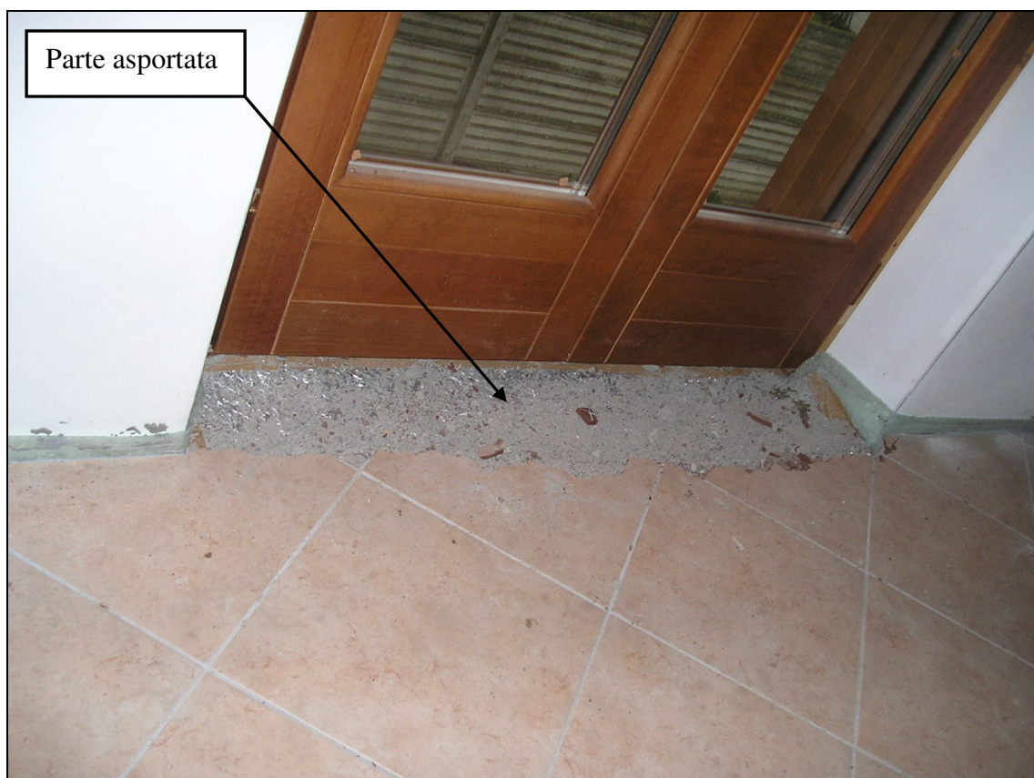
Fig. 4 – particolare del pavimento e massetto asportato
